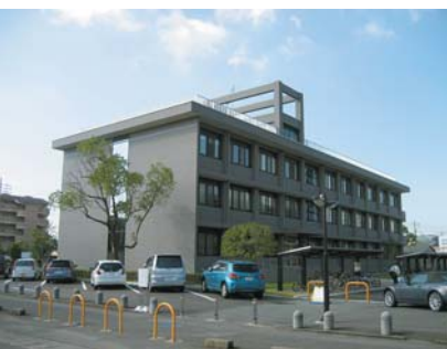
省エネを踏まえた建物改修 (理工学部3号館改修)
